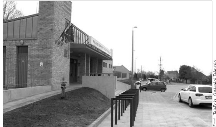
A földes területet térkő burkolat váltotta fel
