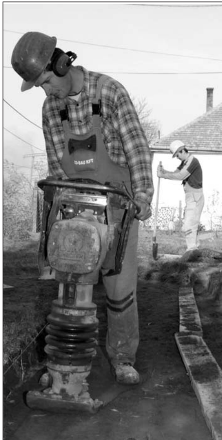
Járda épül Gyapán, munkában a Micro-center Paks Kft.
