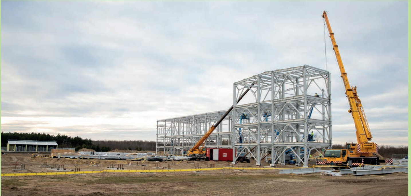
Folyamatban a felvonulási terület első épületeinek kivitelezése. Fotó: Paks II. Zrt.
