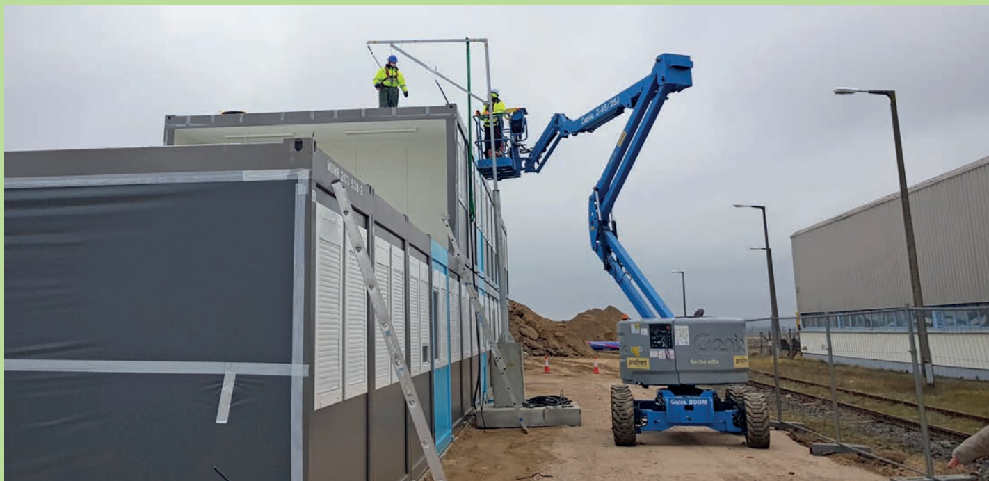
Korszerű munkavédelmi eszközök szolgálják a Paks II. projekten dolgozók biztonságát (Alsipercha leesésvédelmi rendszer) Fotó: Paks II. Zrt.
