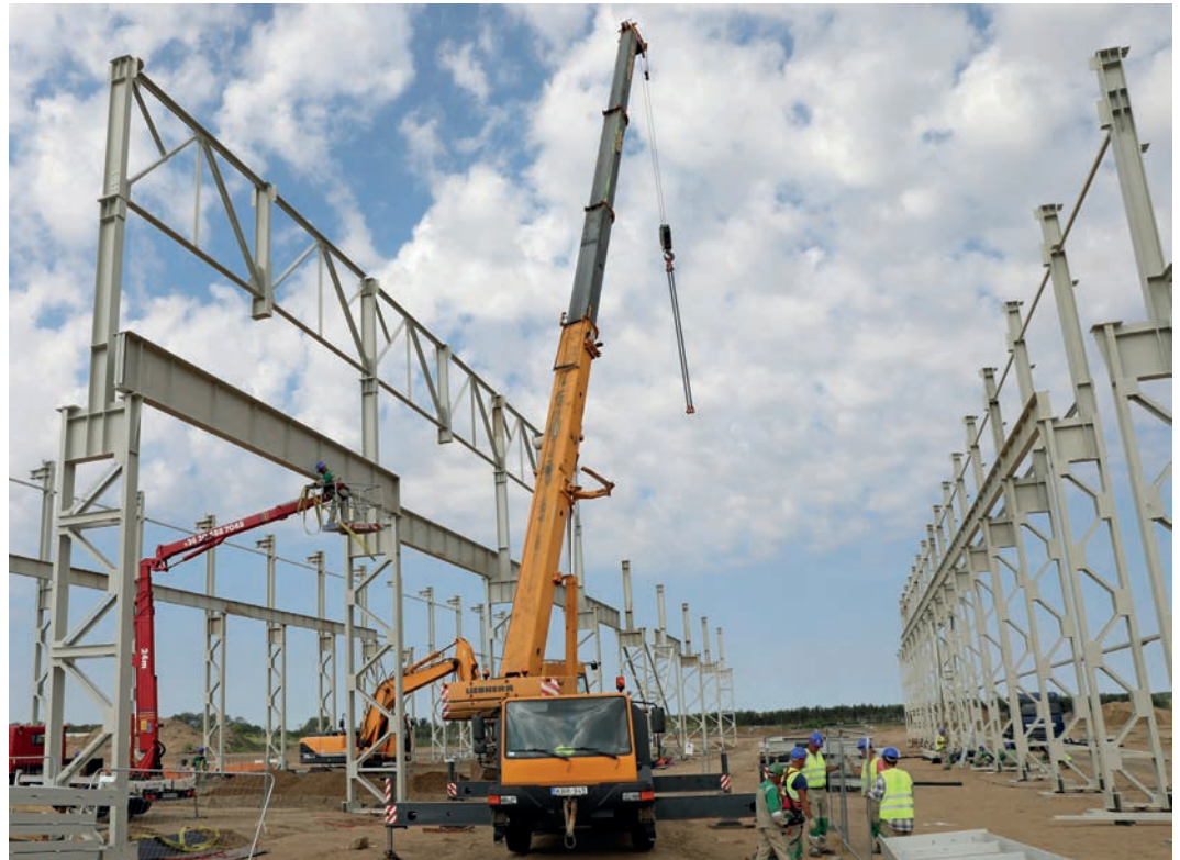
Épül az acél- és betonacél-összeszerelő üzem
