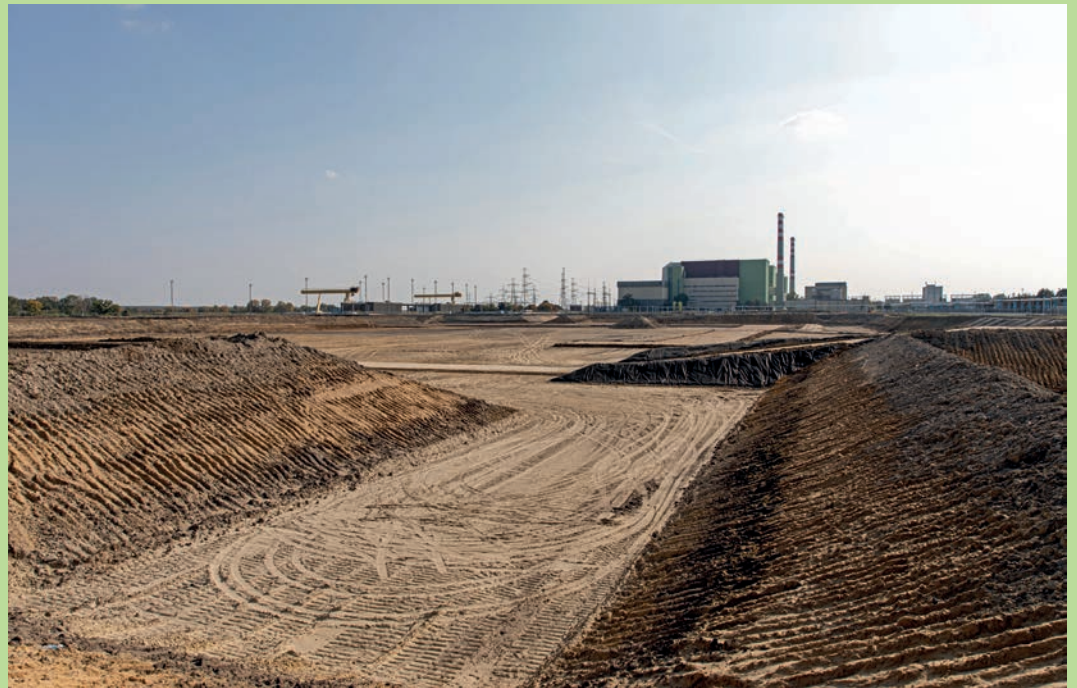
Öt méteres mélységről végzik el a talajszilárdítást
